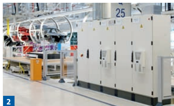
1) Baukastensystem für den Aufbau von Energiehauptverteilung, Automatisierungstechnik, Gebäudeinstallation und IT-Lösungen. 2) Schaltschränke bei BMW.
